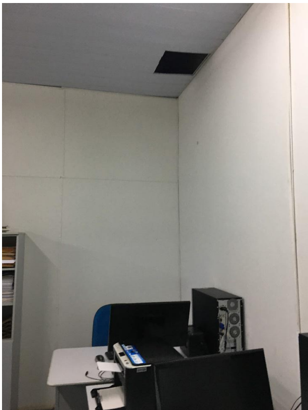
SALA 01 – FORRO A REPARAR
