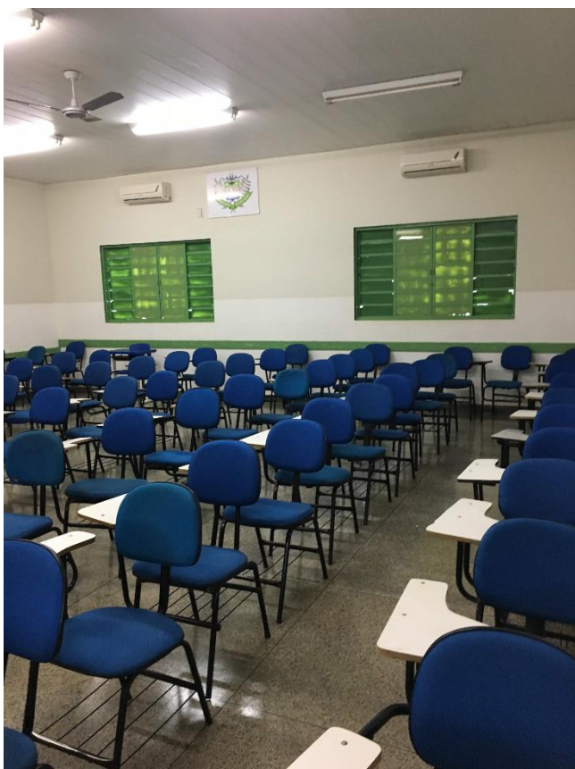
SALA 07 – JANELAS SUBSTITUÍDAS POR JANELAS EM VIDRO TEMPERADO
